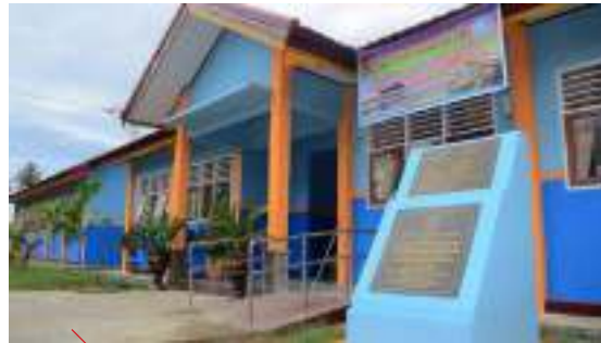
SMPN Bulango Selatan, di kab. Bone Bolango. Pembangunannya dilaksanakan oleh Komite Pembangunan Unit Sekolah Baru yang merupakan perwakilan warga masyarakat setempat.
